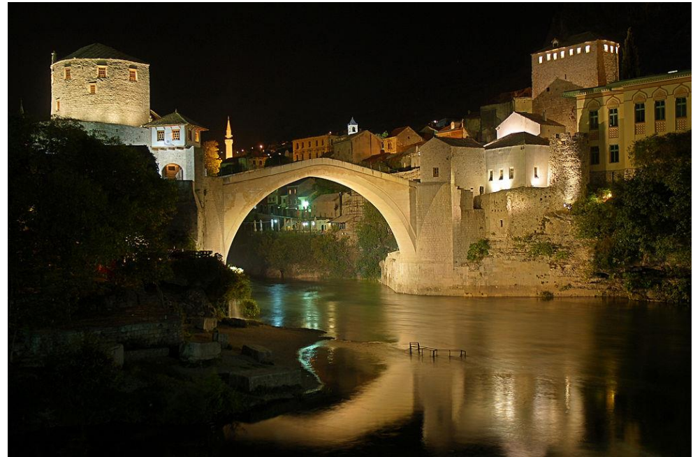
A Ponte de Mostar restaurada
